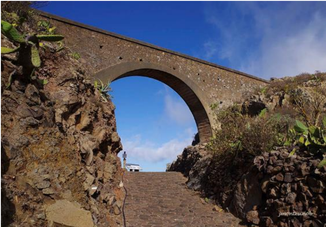
Arco del mirador de Arure para sostener el canal que llevaría agua a La Mérica. Foto: J. Montesino B.
