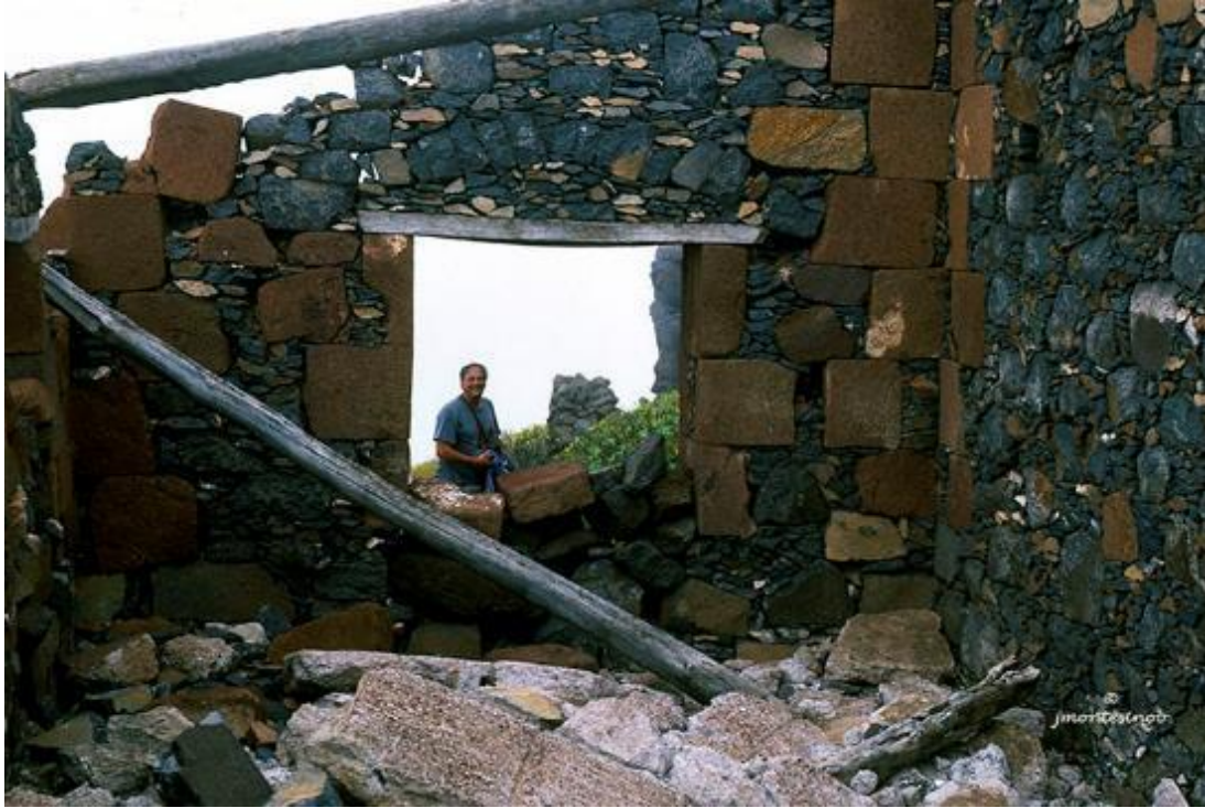
Ruinas de la casa de "los Casanova" junto a los hornos de cal, para vivir el encargado de la calera.
